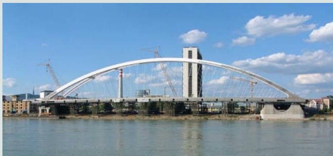
V každom ukotvení lana z oblúka je v mostovke snímač, ktorým sa kontroluje správne napätie lana. Snímače, meranie, metodika a princíp merania boli vyvinuté na Katedre experimentálnej fyziky FMFI UK.
