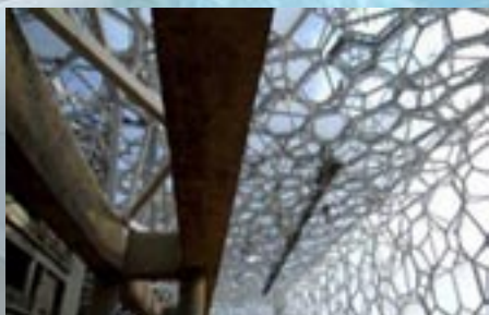
Pohľad zvnútra na rozostavanú konštrukciu plaveckého štadióna
