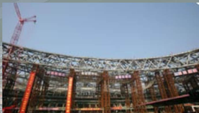
Podpery použité pri stavbe štadióna
