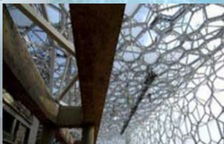
Pohľad zvnútra na rozostavanú konštrukciu plaveckého štadióna
