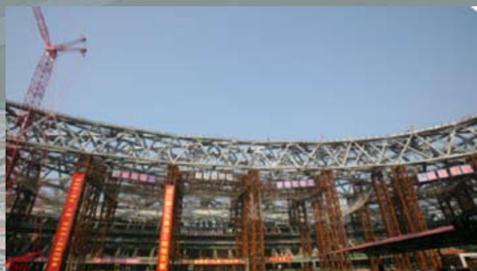
Podpery použité pri stavbe štadióna
