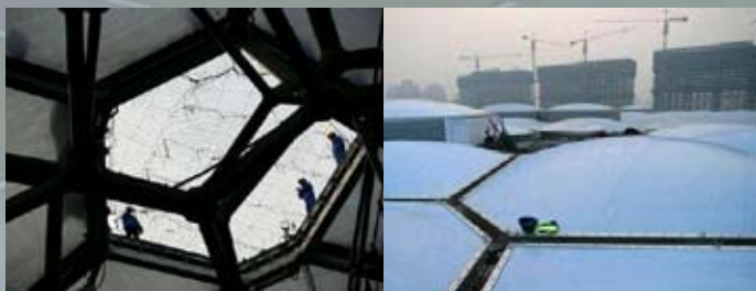
Ukladanie ETFE vankúšov na konštrukciu plaveckého štadióna
